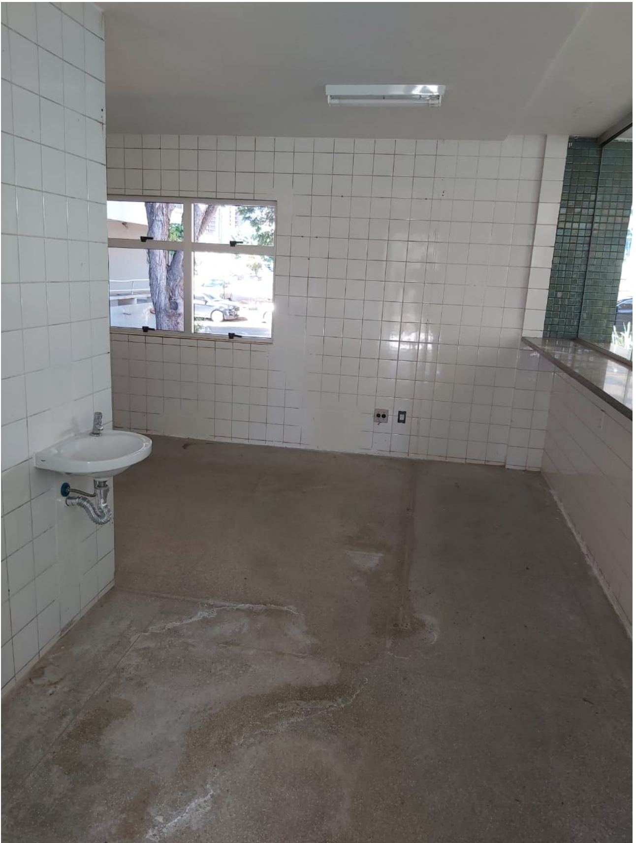
Anexo III - Do TR - Foto 04/06 - Área interna, Vista Interna
